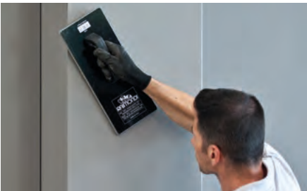
Posata la lastra, batterla o vibrarla dal centro verso l'esterno, parallelo lato corto, per compattare l'adesivo espellendo l'aria.
