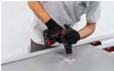
Per la realizzazione di fori si raccomanda l'uso di frese diamantate avendo cura di bagnare costantemente la superficie.
