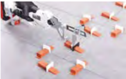
Utilizzare sistemi di livellatura per assicurare una installazione appropriata e rendere perfetta la planarità della superficie posata.
