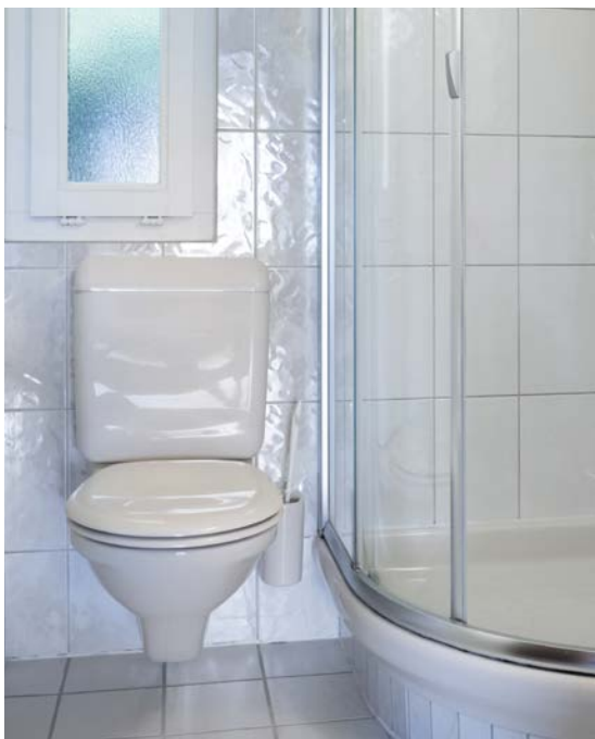
PŘED: WC se splachovací nádržkou na omítku
