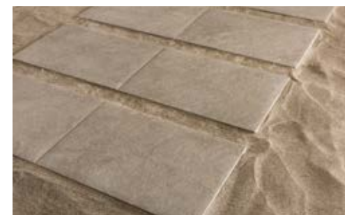
Posa su sabbia . Installation onto sand
