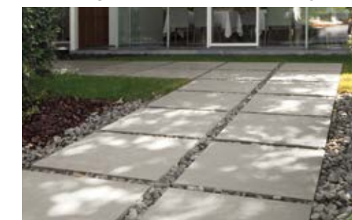
Posa su ghiaia . Installation onto gravel
